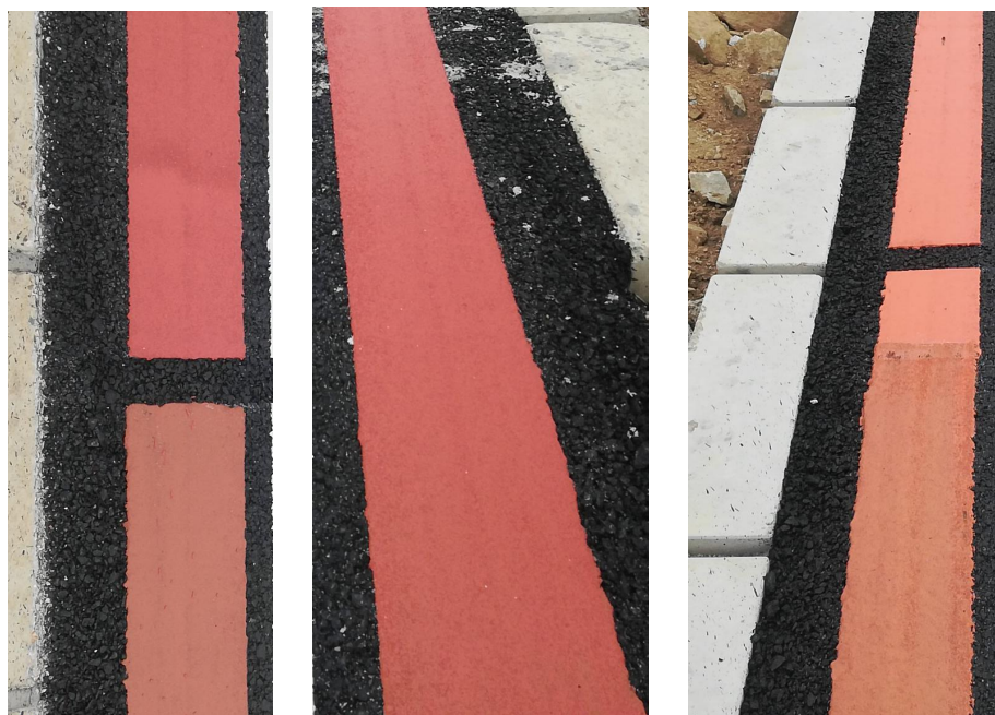
彩色标线监理施工照片
